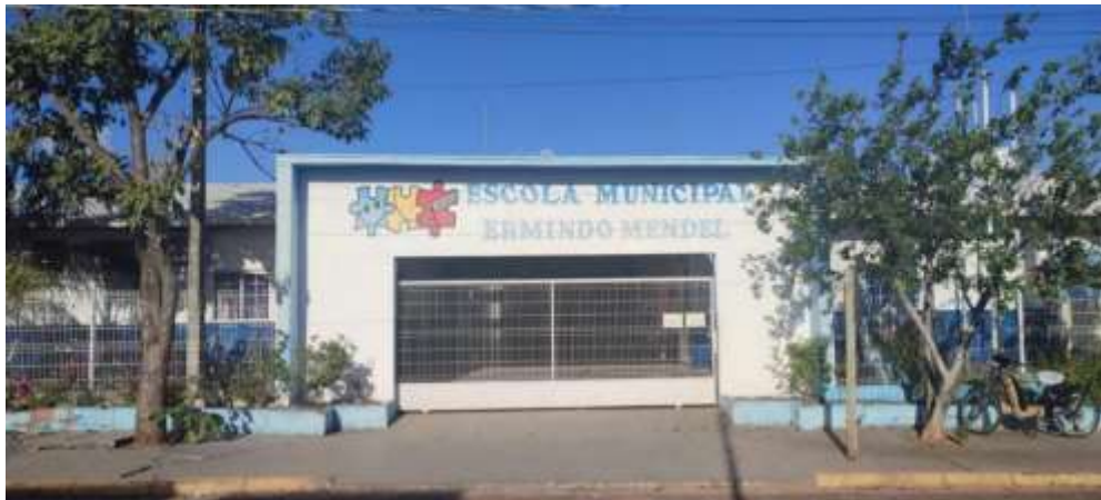
Figura 4 – Fachada principal da instituição de ensino onde o projeto foi desenvolvido.
